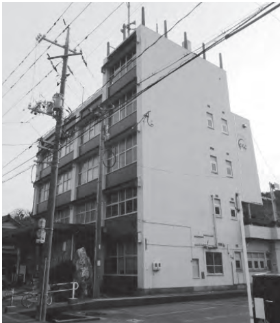
緊急避難場所に改修着手 (泊支所)
