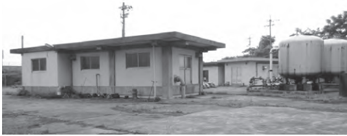
水道の安定供給をめざし施設保全（羽合浄水場）
