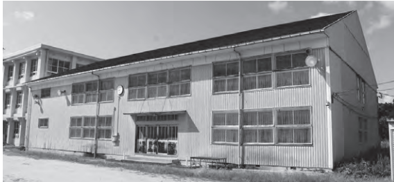
解体される体育館
