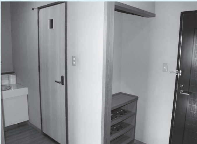
シャワールームの設置へ室内改修
