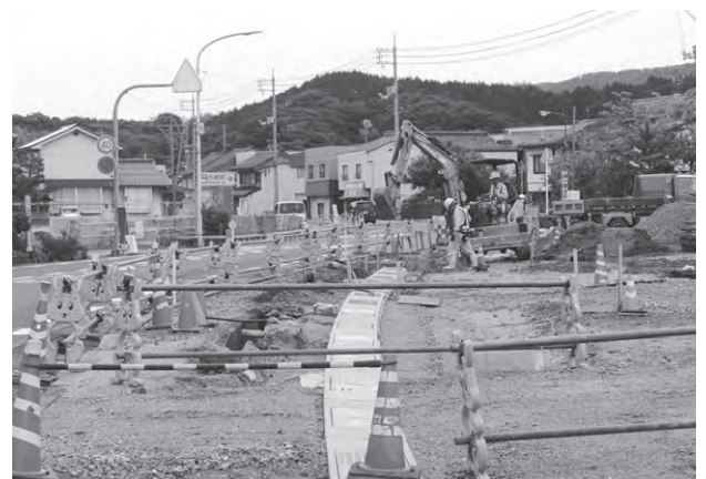
工事が進む松崎駅前
