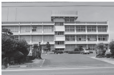
解体される旧北浜中学校
