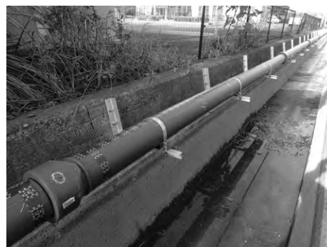
倉吉市から水の供給を受ける水道管（耐震管）を設置（田後地内）
