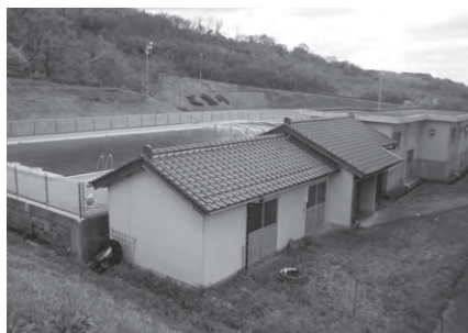
屋外トイレを改修 (泊小学校)
