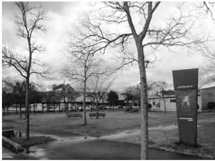
建設が遅れた羽合第2放課後児童クラブ（ハワイアロハホール東側建設地）
