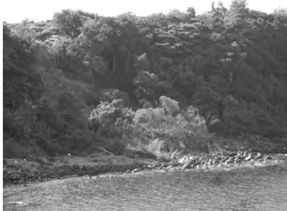
台風19号で、のり面が崩壊した 尾後ノ鼻岬（小浜）
