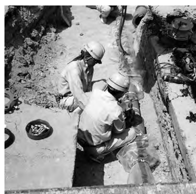
水道管（耐震管）布設工事状況
