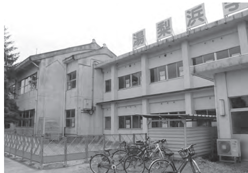
耐震化される校舎
