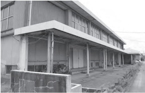
解体撤去される羽合体育館
