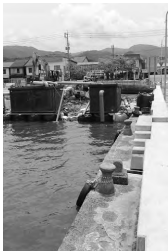
整備が進む護岸工事 (松崎駅前)
