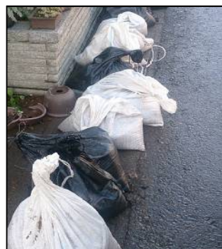
浸水対策の土嚢袋 （台風等で効果を発揮）
