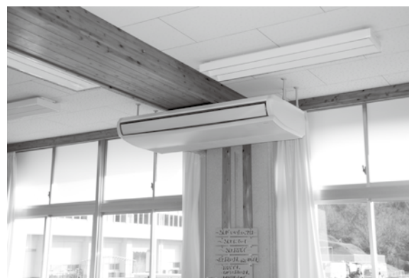
全小学校にエアコン設置 (泊小学校)
