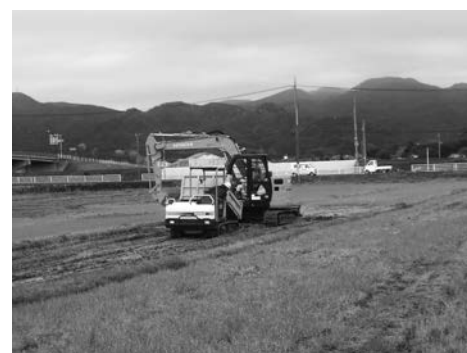
水田の土地改良工事
