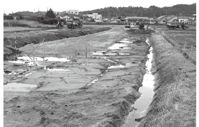
造成工事が始まる (松崎駅南梨団地)
