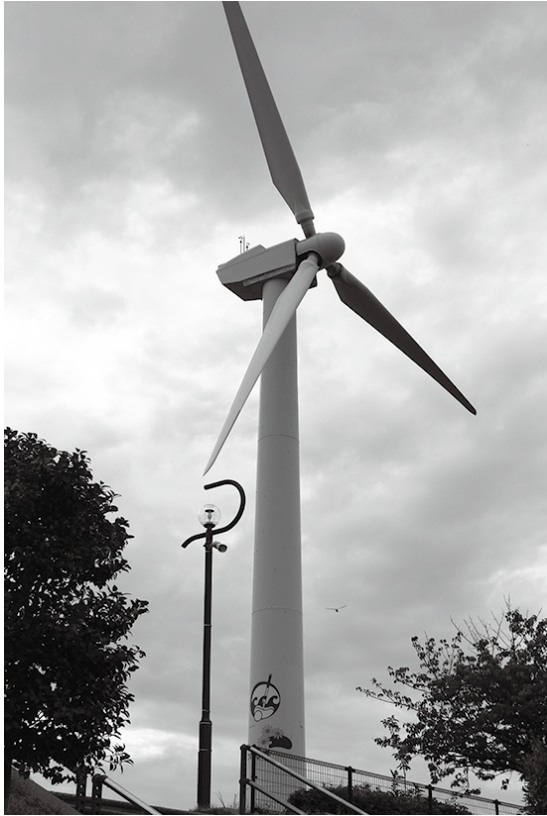
停止中の風力発電施設 (潮風の丘とまり)
