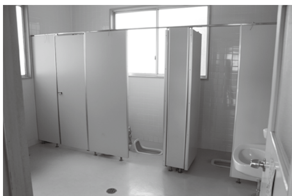
改修予定のトイレ（東郷中学校）
