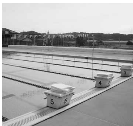
事故のあった羽合小学校プール
