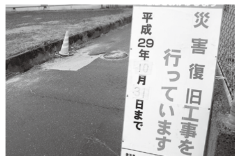
道路復旧工事中（旭）
