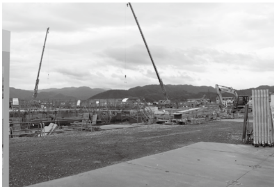
順調に進む中学校建設
