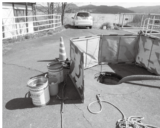
下水道管の長寿命化工事（長江）
