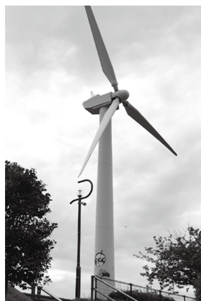
故障中の風力発電施設
