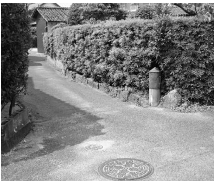
改良が望まれる集落内道路
