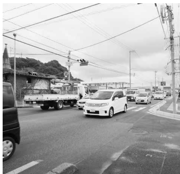
渋滞対策が急がれる国道179号（田後）
