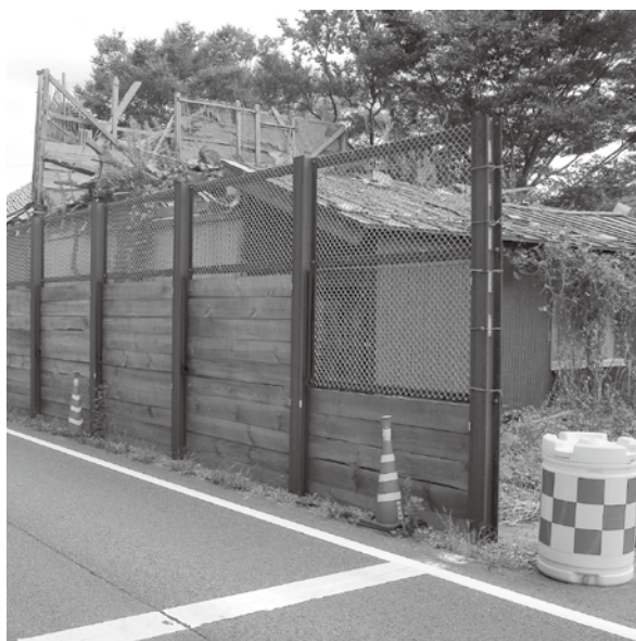
解体される危険家屋（方地）
