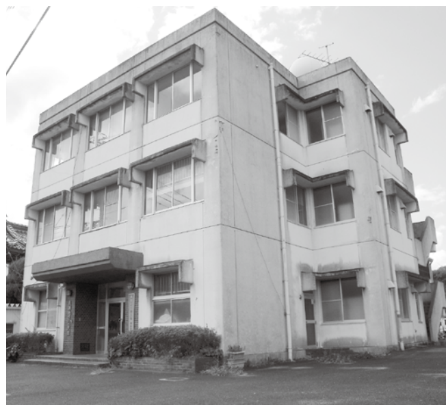
老朽化により解体（商工会羽合支所）
