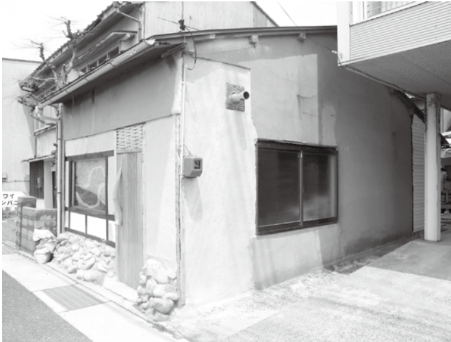
空き家を店舗に自力で改修中（松崎）
