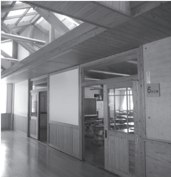
暑くて勉強に支障がある東郷小学校
