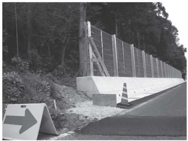
安全な通行へ道路改良（景宗寺長和田線）
