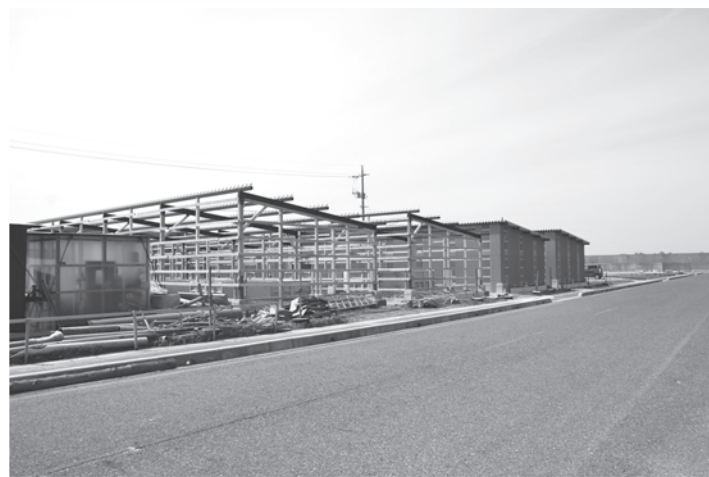
建設が進む陸上養殖施設（泊漁港内）
