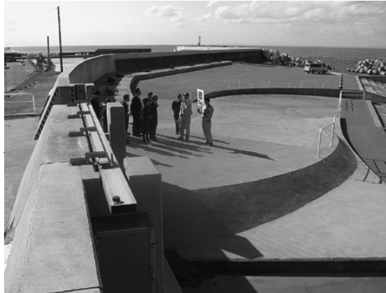
海岸線防潮堤の開閉門（入善町）
