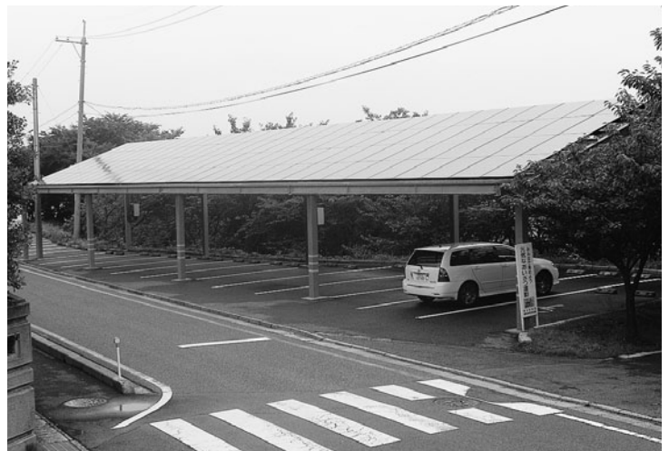
「泊小学校」に設置されている太陽光発電施設
