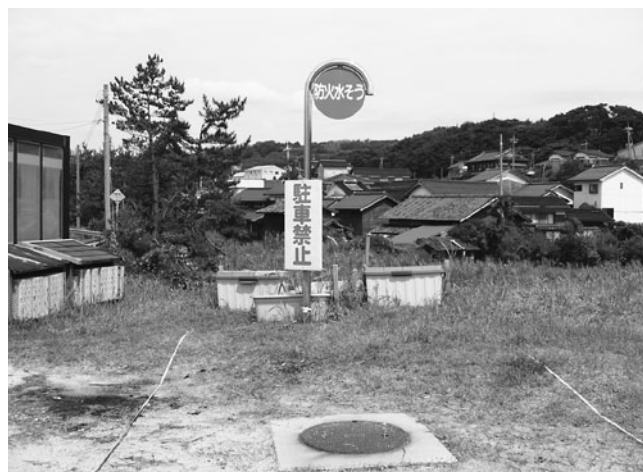
地下式の防火水槽
