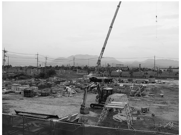
着々と工事が進む「幼保一体化施設」
