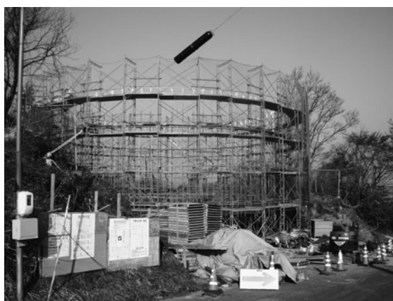
工事が進む羽合新配水池
