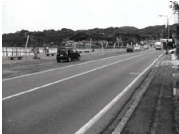
道路改良計画中の県道倉吉青谷線
