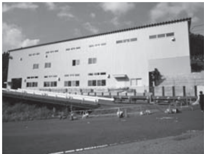
ウラン残土のレンガ加工場（三朝町）
