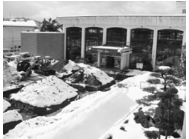
急ピッチで進む庁舎改修工事 (旧中央公民館羽合分館及び玄関前)
