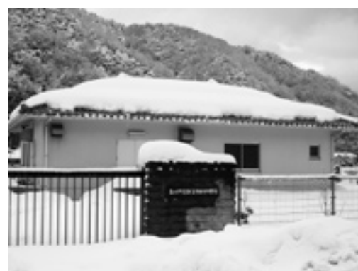
公共下水道と料金統一される 農業集落排水処理施設（舎人地区）
