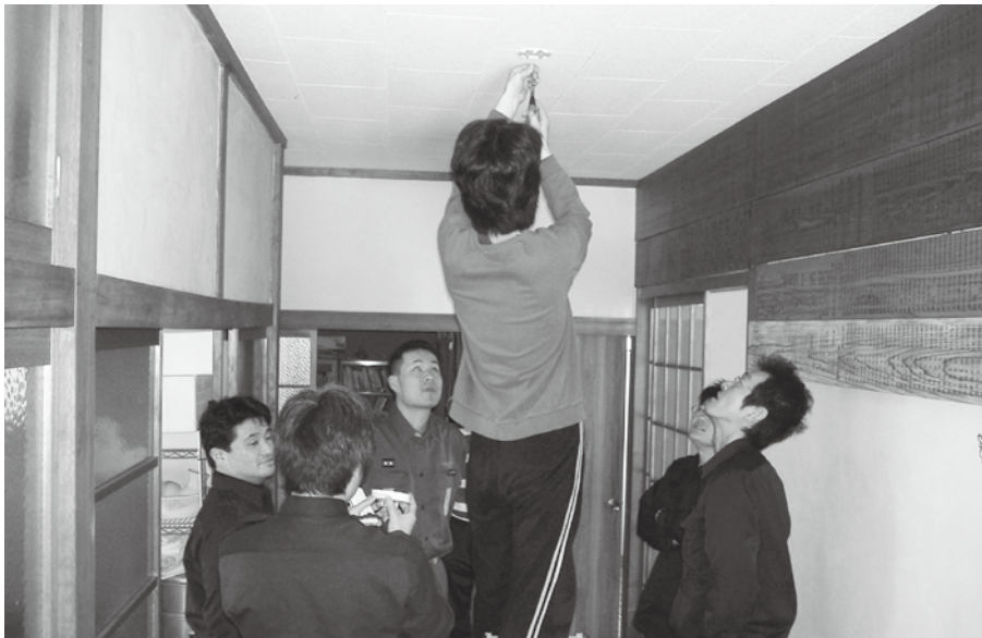
命を守る火災警報器の取り付け作業
