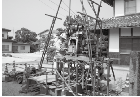
手動ポンプ設置のための井戸整備
