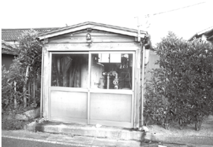
浜地区簡易水道施設
