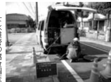
下水道管の腐食調査
