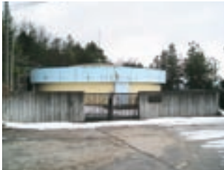
田後第2配水池
