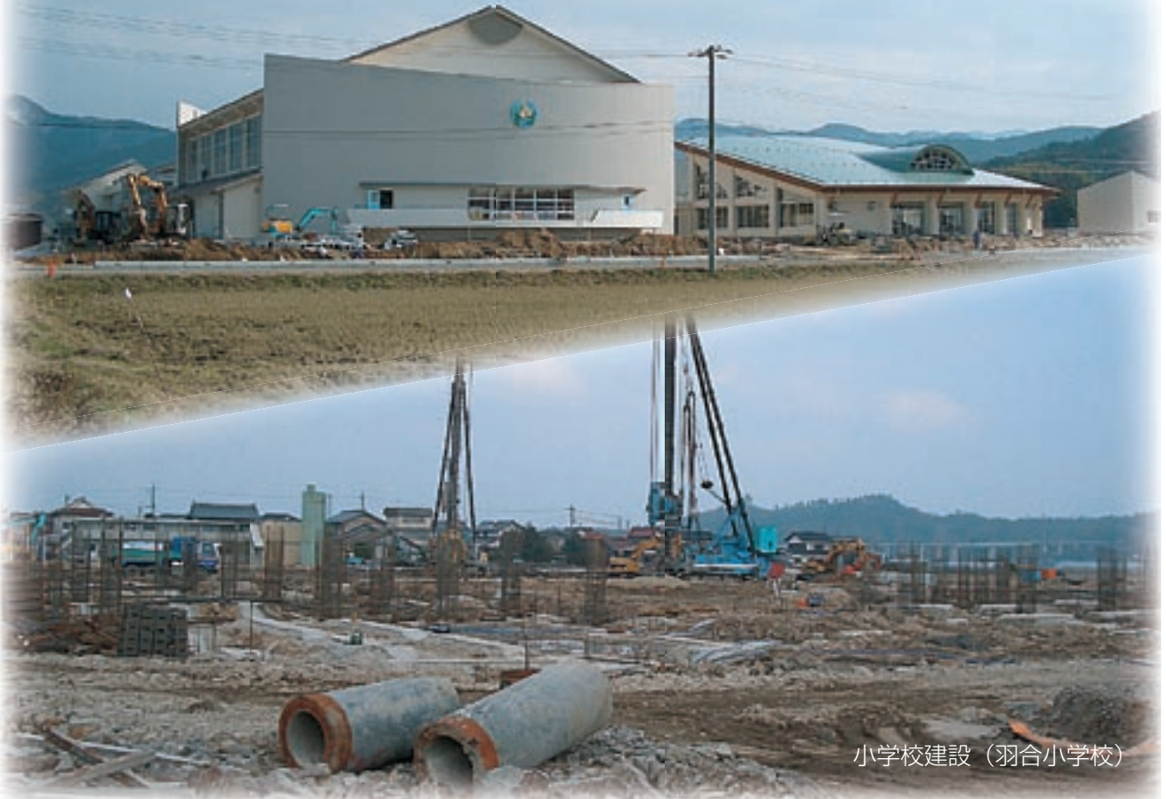
小学校建設（東郷小学校）
