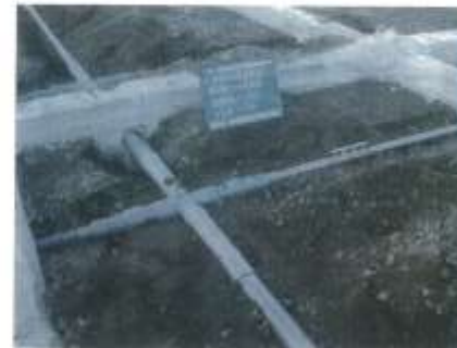
写真① 土間コンクリート下ガス抜き管
