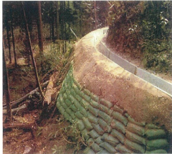
山腹水路ノ改修・法面補強
