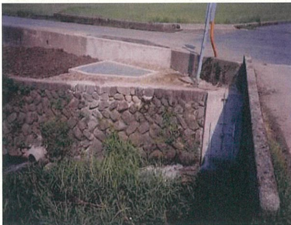
簡易ゲート・柵の設置
