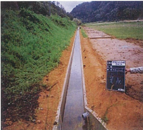
農業用排水路（二次製品の設置）
