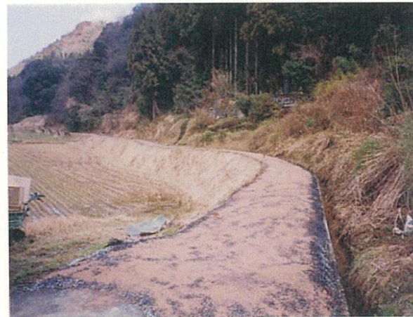
簡易な農道舗装
