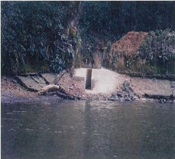
放置ため池（余水吐改良）
