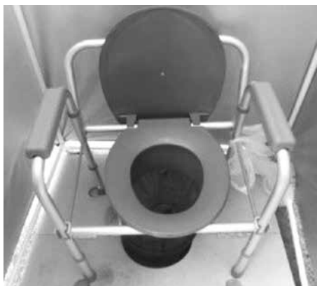
災害時に設置するマンホールトイレ (出典：国土交通省ホームページ)
