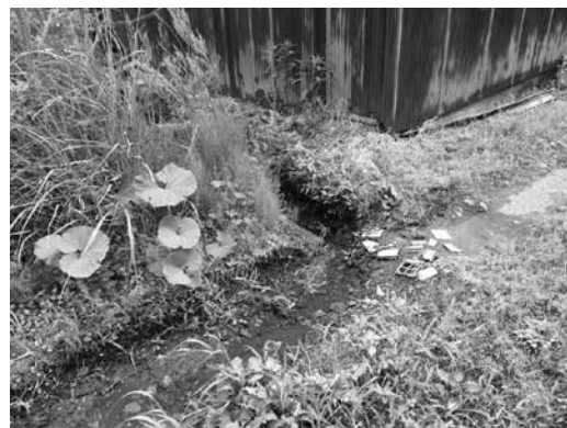
山下がり水の排水路
