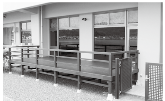
新設された1階テラス
