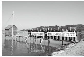
四ツ手網復旧工事(平成30年3月)
