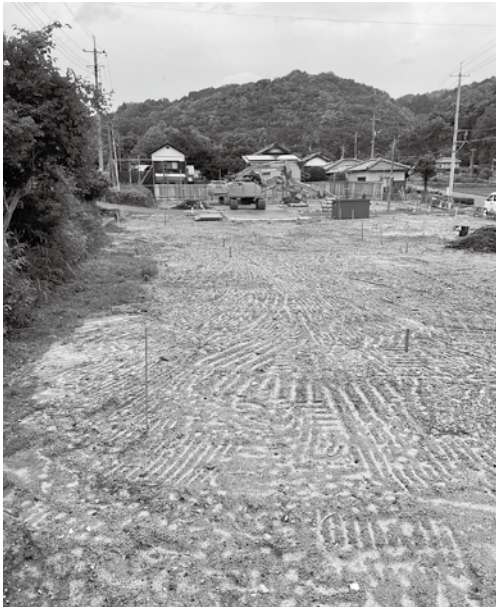
近隣に配慮し、杭を残す (堀の内団地跡地)
