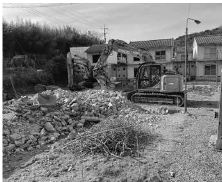
急ピッチで解体が進む堀之内団地（松崎）
