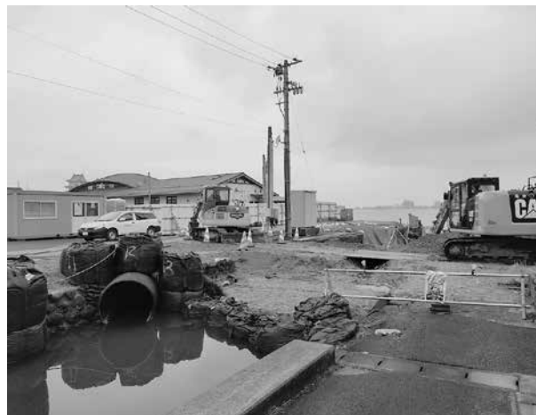
浸水対策工事が進む新町川
