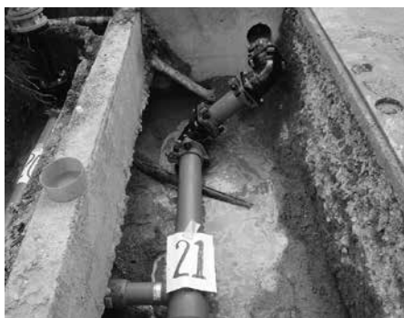
耐震管へ布設替え
