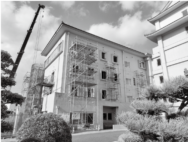
工事が進む水明荘西館
