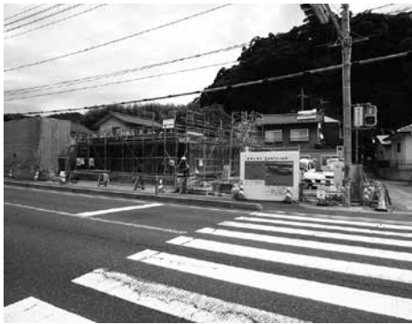
建築中の町営住宅（松崎）
