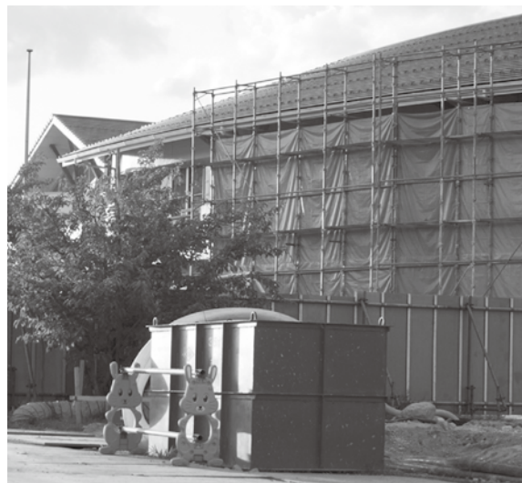
工事が進む羽合小学校
