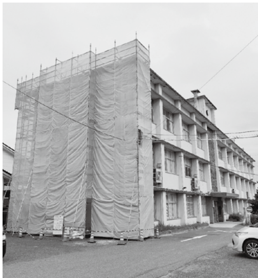
外壁改修（羽合西コミュニティ施設）
