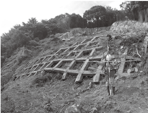
泊中央線復旧工事着工へ
