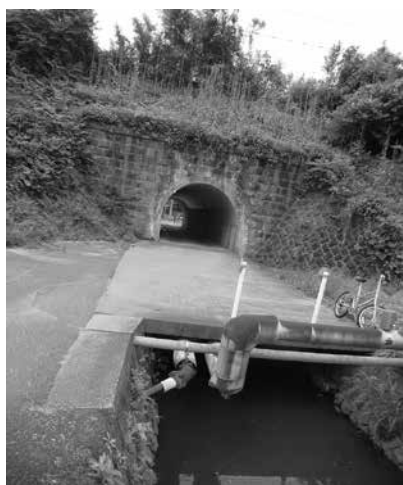
拡幅・防災工事が望まれる 石脇 すい 隧道
