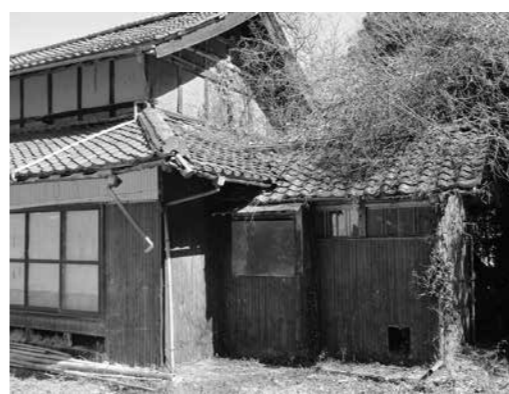
荒廃が進む旧岡本邸
