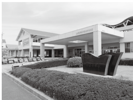
増築が検討されている羽合小学校
