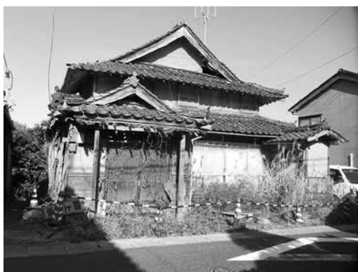
高齢化が進む過疎集落の廃屋
