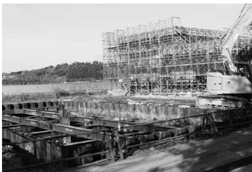
建設が進む龍島ポンプ場 (7月ごろ完成予定)
