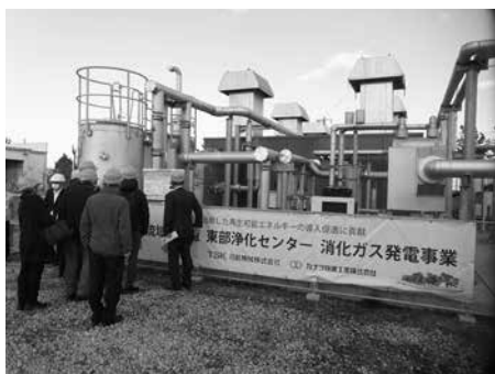
松江市のバイオマス発電設備の視察
