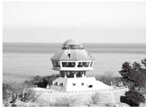
修理する風土記館
