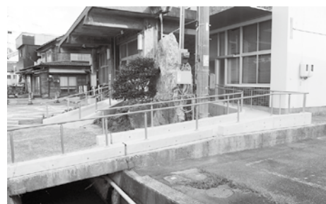
設置されたスロープ
