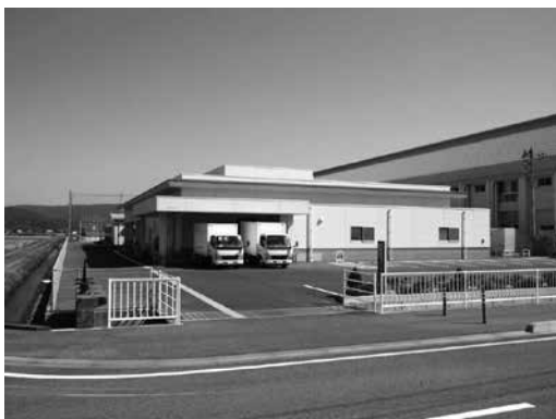
町立学校給食センター (湯梨浜中学校敷地内)
