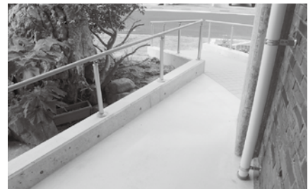
新設のスロープ
