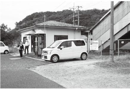
整備が急がれる現泊駅舎
