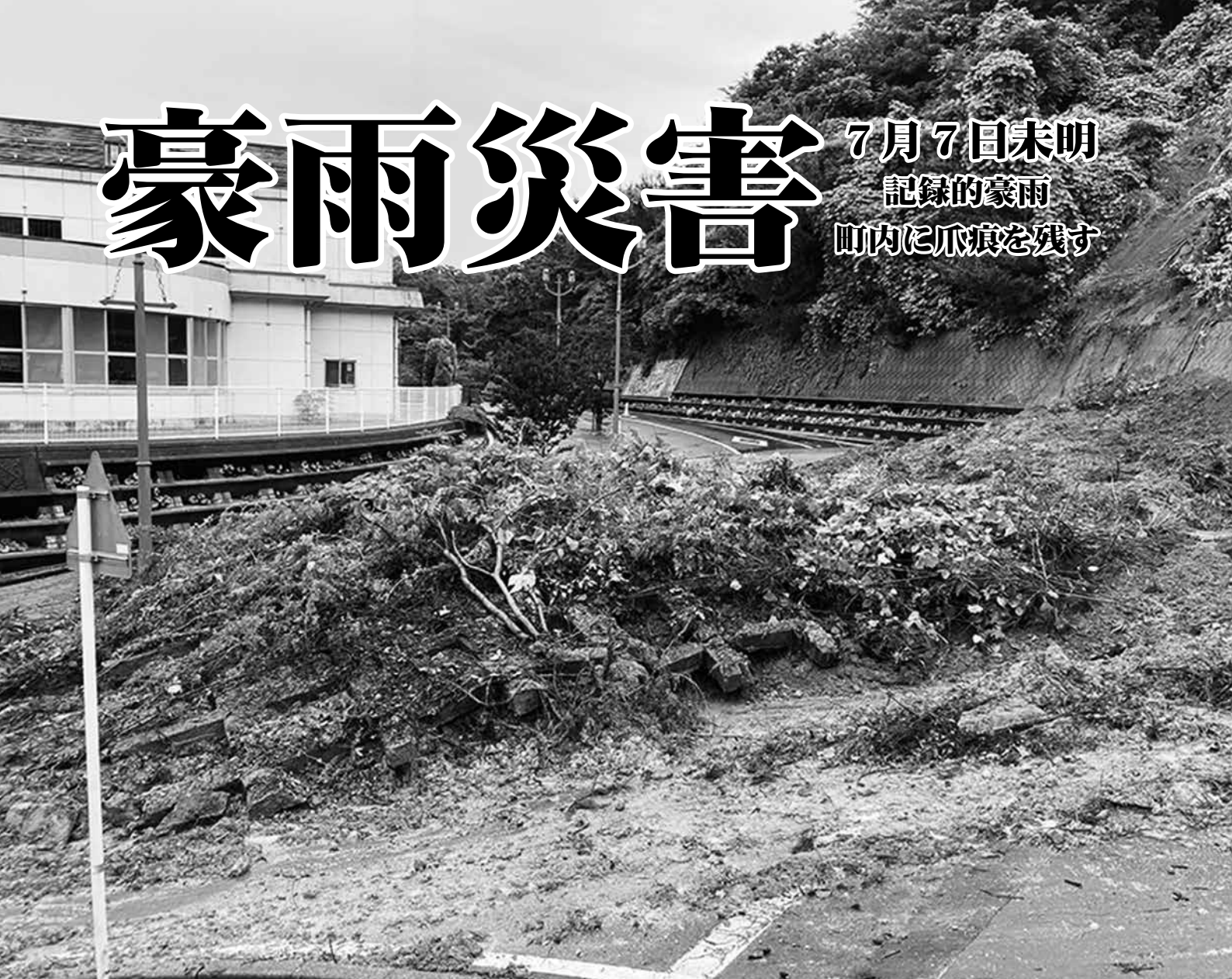
▲あさひこども園近くののり面崩落により、崩れた土砂が道路（町道泊中央線）をふさぐ
