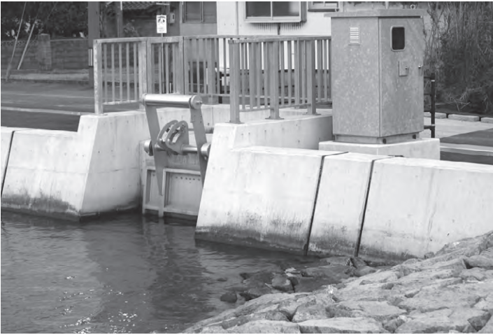
龍島にある現在の樋門
