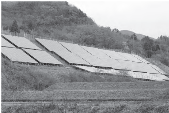
山田谷にある太陽光発電施設
