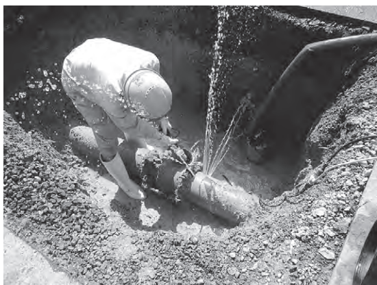
本管の修理（田畑）
