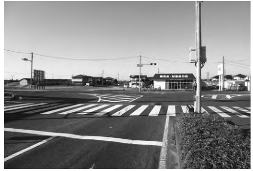
国道179号の延伸に着手（田後）
